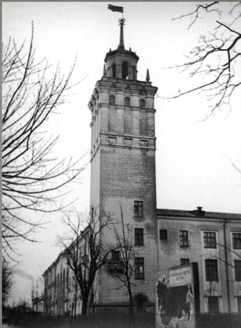
Здание фабрики «8-Марта»
